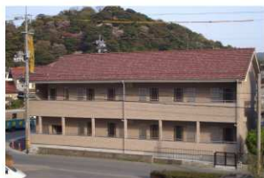
港夢1号の全景です
