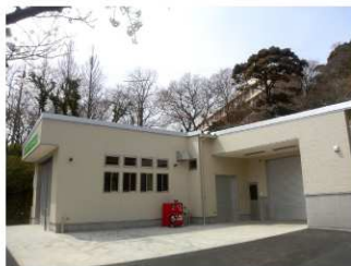
リサイクルセンター外観
